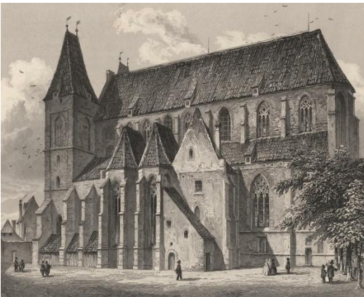
Die Nicolaiikirche in Brieg, Stahlstich um 1850
